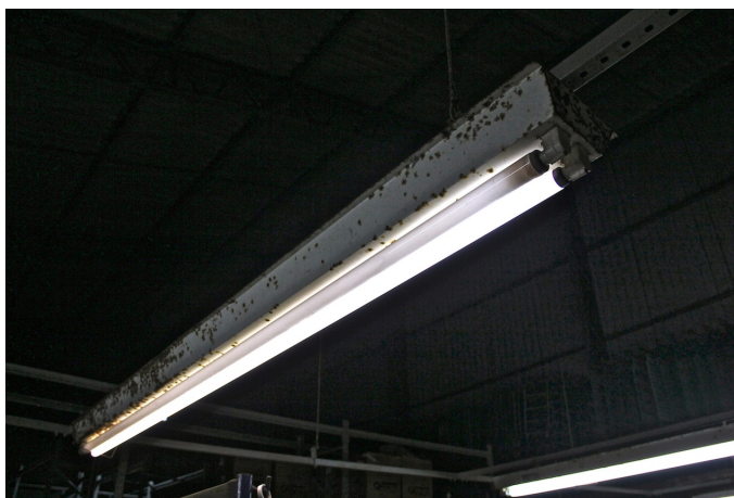
Figura 35 – Luminária com corrosão e lâmpada queimada Fonte: Arquivo Pessoal (2012)
