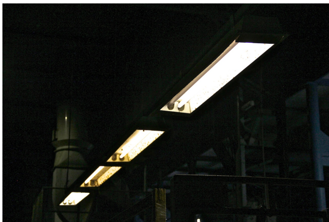
Figura 34 – Luminárias faltando lâmpadas e com lâmpadas queimadas Fonte: Arquivo Pessoal (2012)
